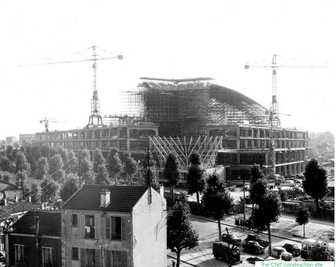
The CNIT construction site
