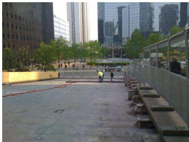
Travaux en cours :
